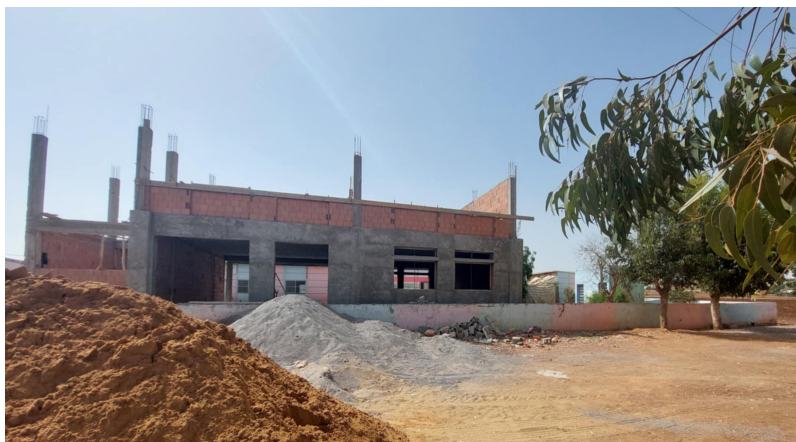
Fot. 2. Lokalna szkoła podstawowa w Al-Karze w trakcie modernizacji (sierpień 2024 roku)
